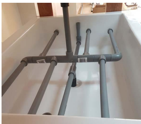
Figura 16. Blower (arriba) y sistemas de distribución de la aireación con tubos de PVC perforados (abajo), en los distintos estanques de cultivo.
