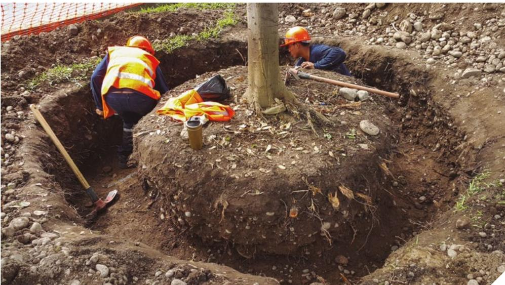
**Figura 1.** Excavación manual para preparación de cepellón. Fotografía tomada antes de la pandemia de COVID-19
