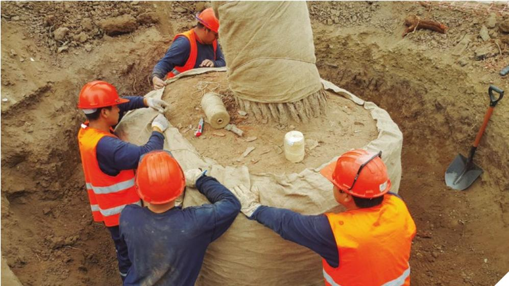
**Figura 2.** Colocación y cosido de tela de yute para protección de cepellón.
