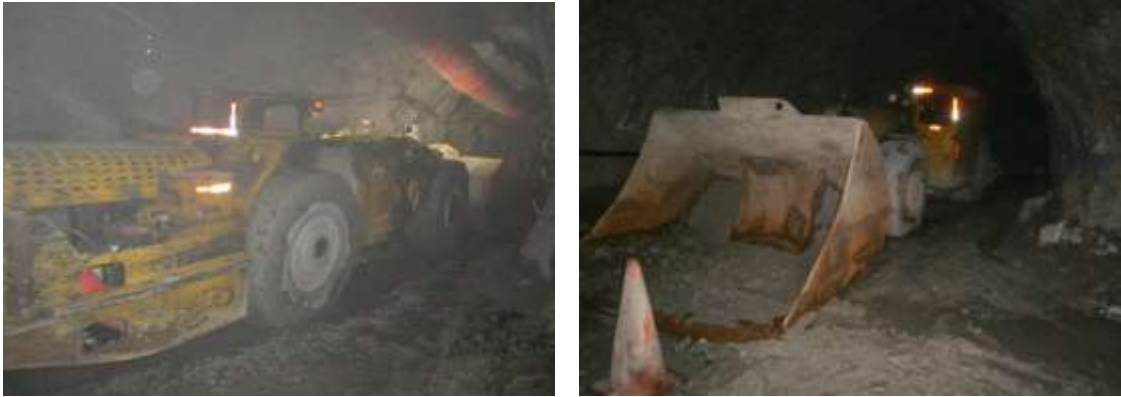
Figura N° 8 Limpieza de material de voladura
