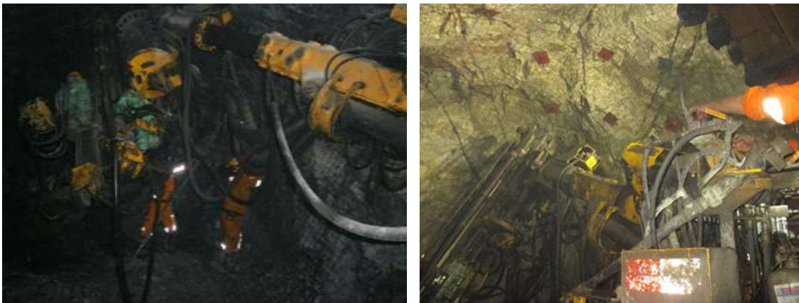
Figura N° 9 Sostenimiento de labores con equipo Bolter
