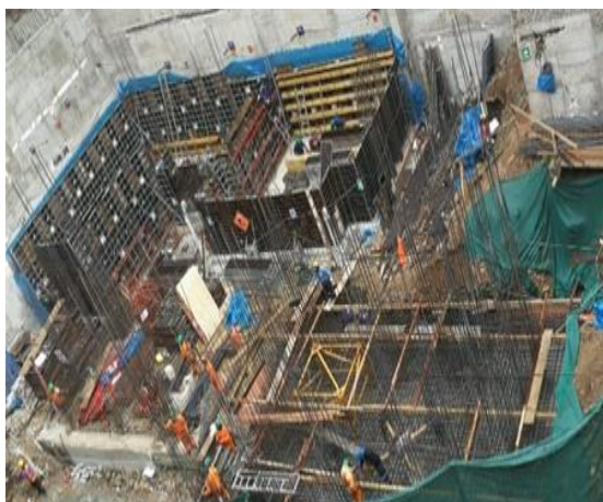
Ilustración 4. Colocación de fierros
