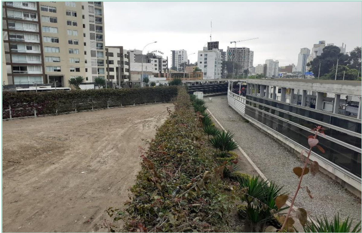
FIGURA 2. Barrera visual con la estación de BRT. Elaboración propia (2019)
