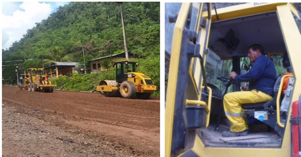
Figura 34: Trabajos de bases granulares
