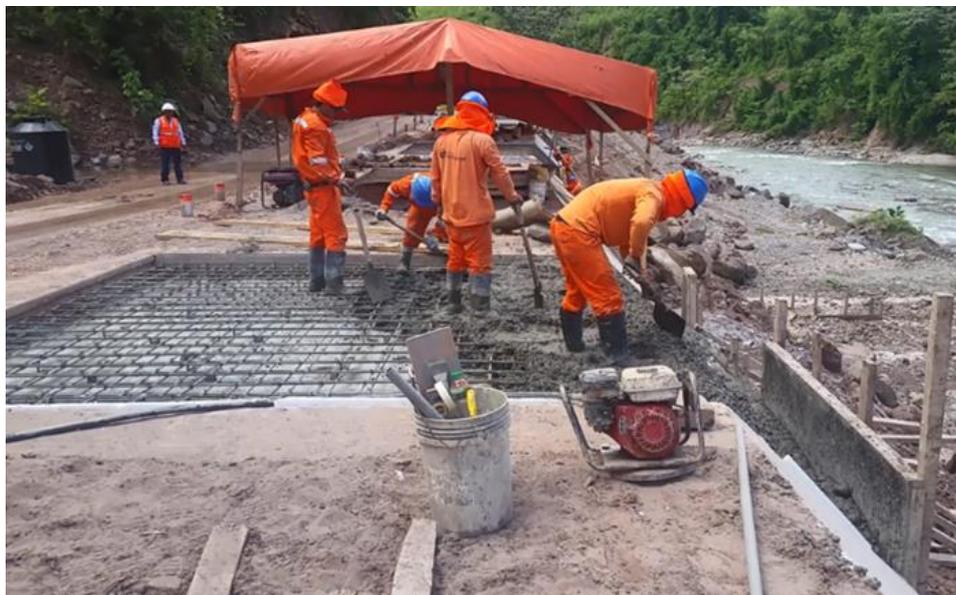
Figura 38: Trabajos de Acero de refuerzo y Concreto estructural
