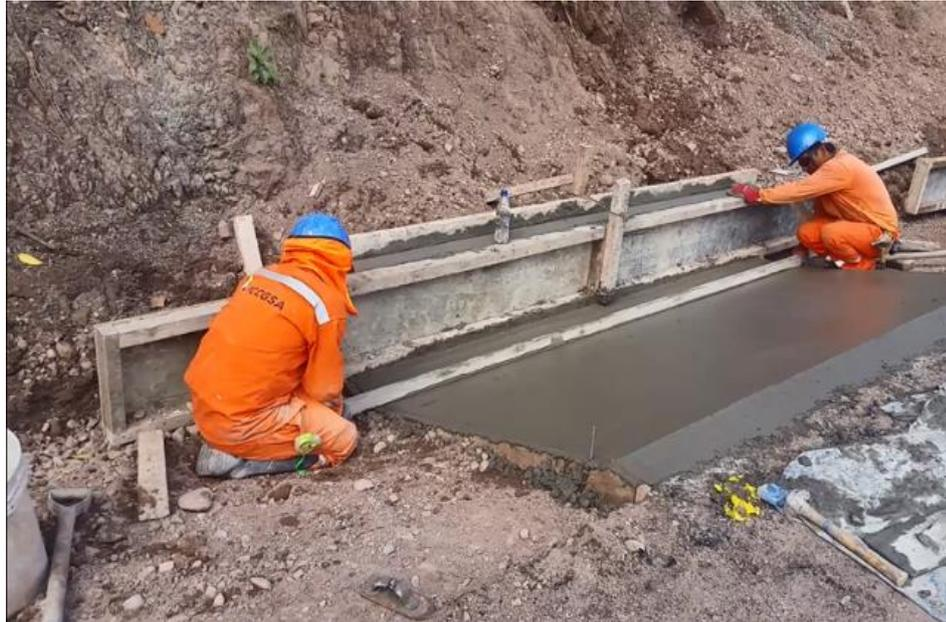
Figura 40: Trabajos de cunetas revestidas de concreto
