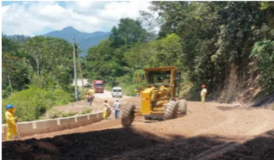
Figura 33: Trabajos de sub-bases granulares
