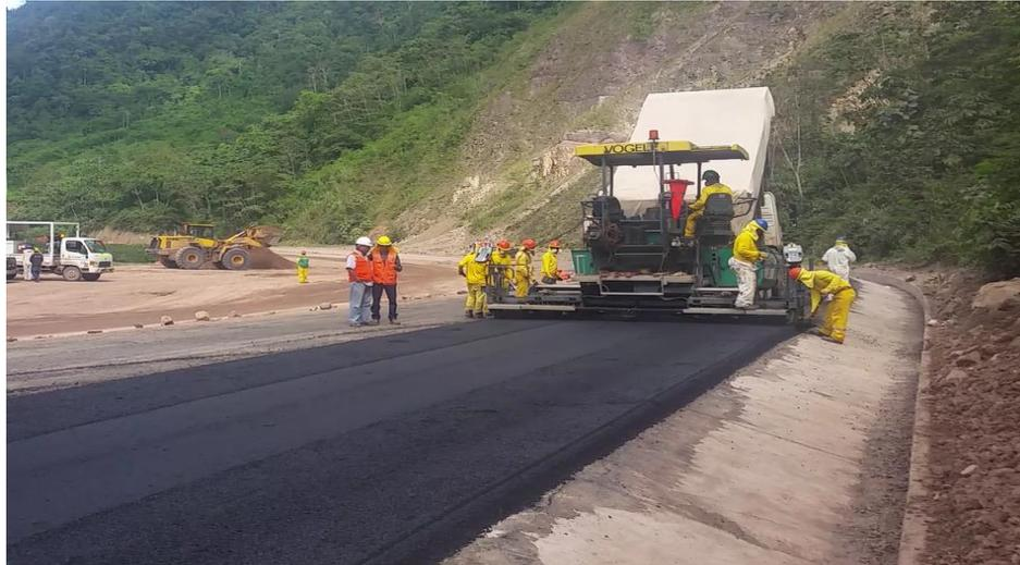
Figura 36: Pavimento de concreto asfáltico en caliente
