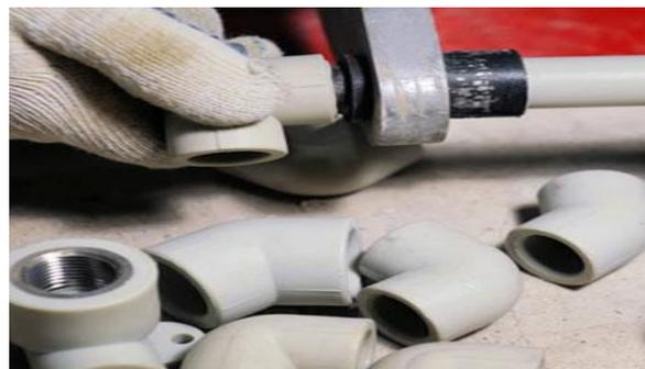
*Figura 30: Soldadura de los enlaces reductores*
