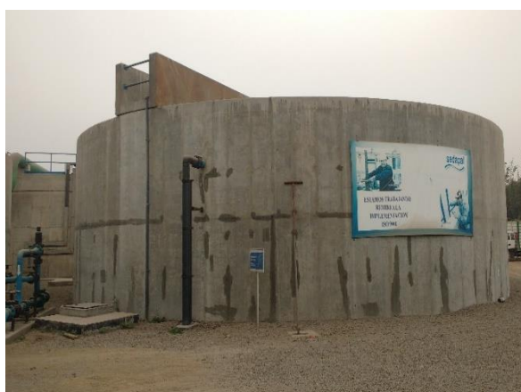
Planta de Tratamiento de Aguas Residuales Santa Clara (SEDAPAL)
