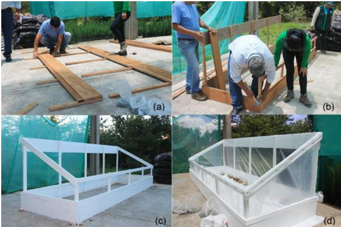
Figura 4. Construcción de la cámara de sub-irrigación: (a y b) Armazón de la cámara, (c) Pintado de la cámara y (d) Forrado de la cámara.
