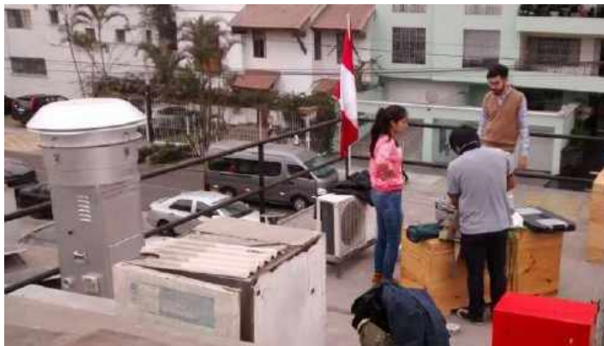
Figura 8. Instalación de los equipos de monitoreo en la azotea de la
