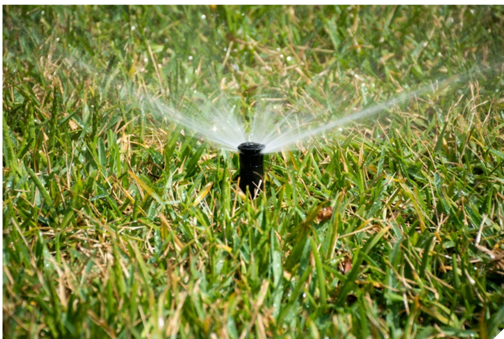
Figura 10. Sistema de riego tecnificado con difusores
