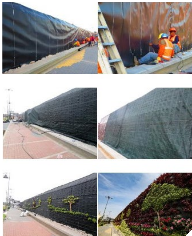
Figura 2. Proceso de instalación de un jardín vertical
