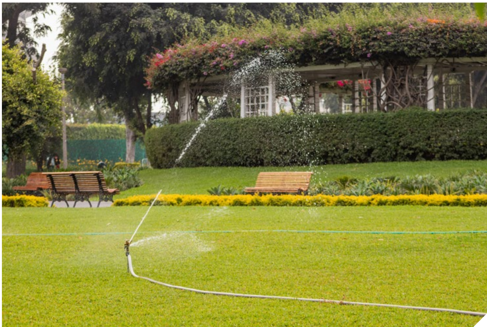
Figura 11. Sistema de riego tecnificado con microaspersor
