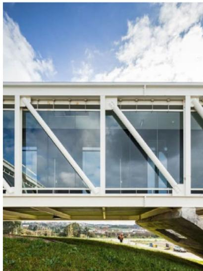
Figura 124: Sistema constructivo Mixto
