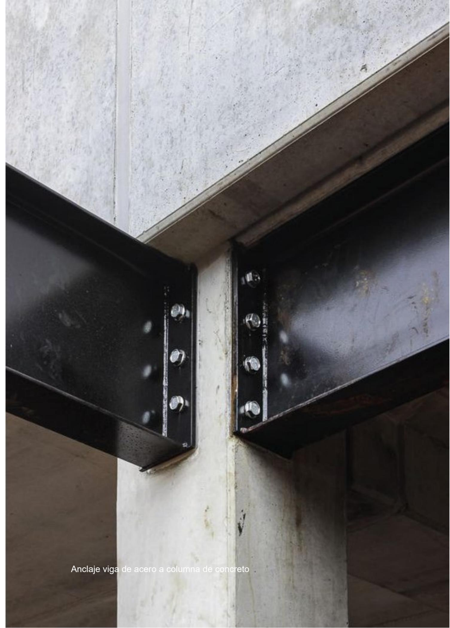
Anclaje viga de acero a columna de concreto
