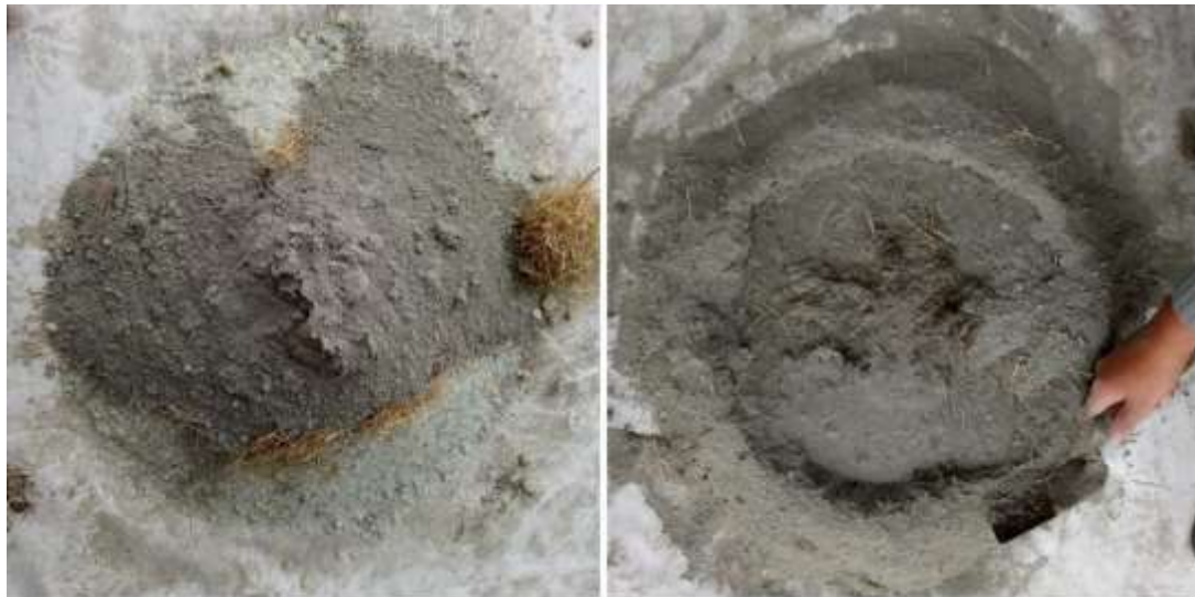
Figura 20. Compactación manual del mortero.
