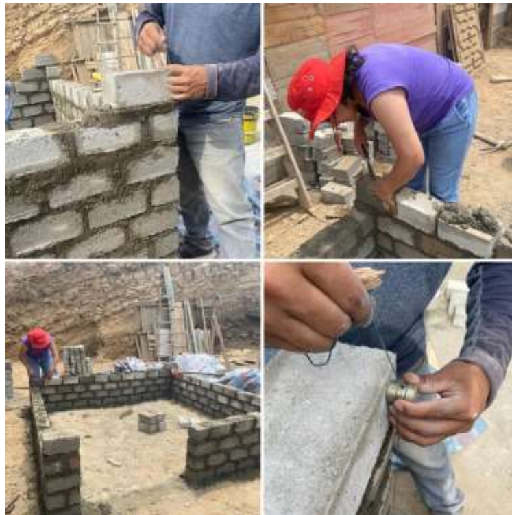
Figura 34. Entrecruzado de ladrillos y trabajo a nivel con plomada.
