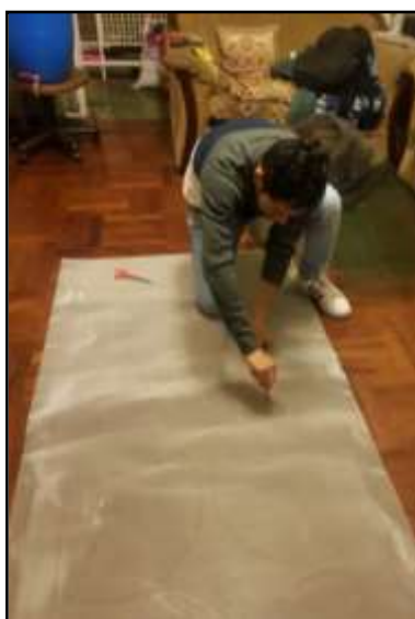
Instalación del VF Y FC
