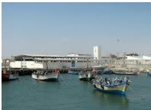
Figura 48. Infraestructura portuaria DPA de San Andrés
