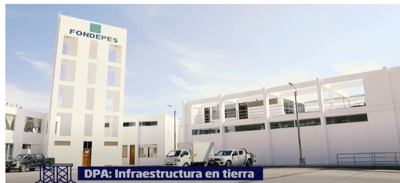
Tanque elevado y zona de fríos
