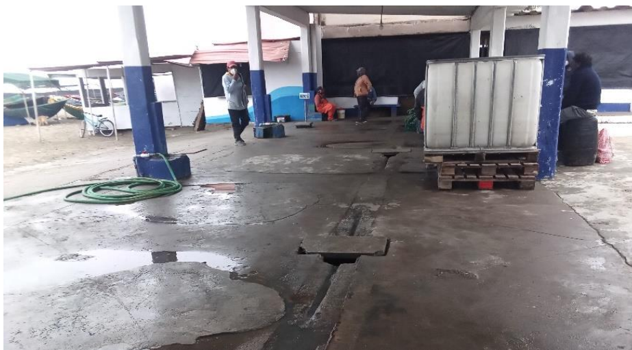
Figura 70 Canaletas de desagüe
