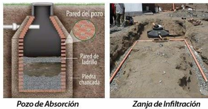
Figura 257 Zanja de infiltración
