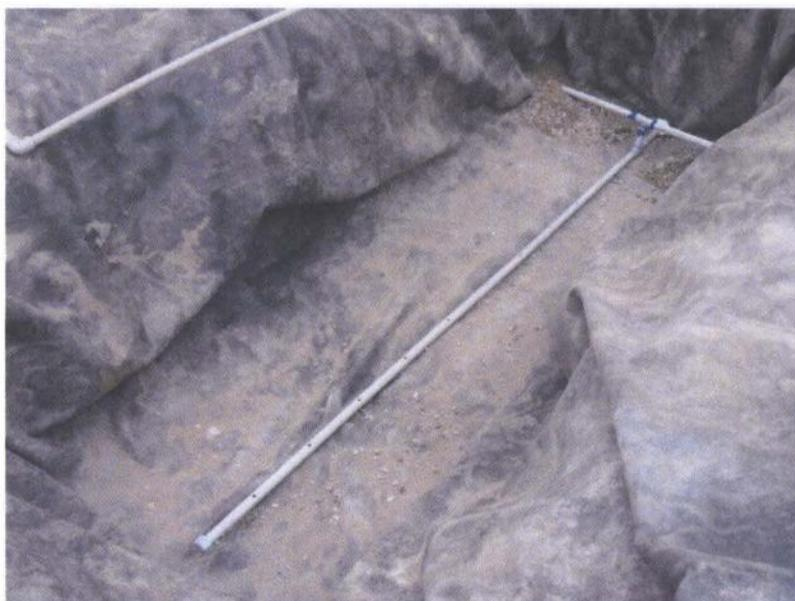
**Figura 4** Vista de la tubería de recolección de PVC de  $\frac{3}{4}$ " de diámetro
