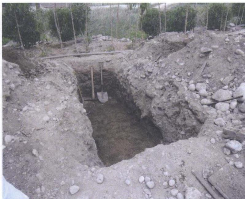
**Figura 2** Excavación de la zanja de 3 m x 1 m x 0.8 m
