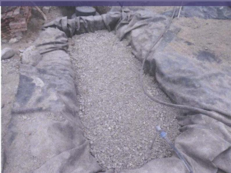
**Figura 11** Capa de piedra chancada de ½" que recubrió el sistema de tuberías de distribución
