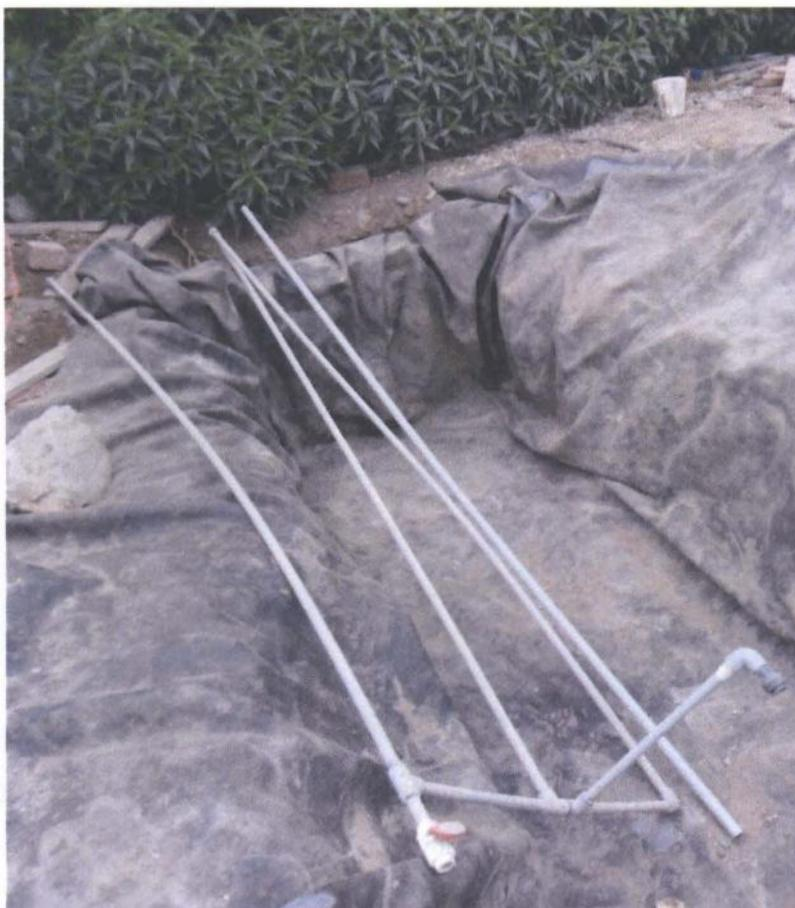
**Figura 10** Vista del sistema de tuberías de distribución de PVC de ½"
