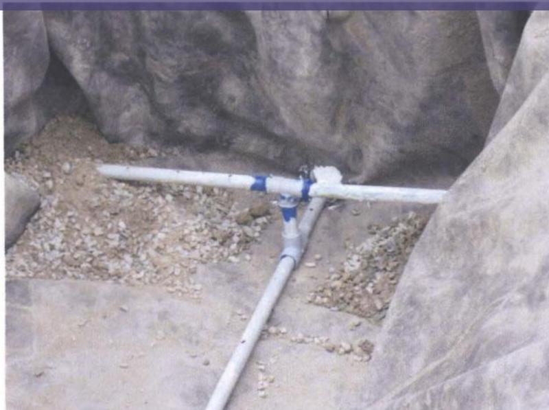
**Figura 5** Vista de cerca de la conexión en forma de "T" de la tubería de recolección
