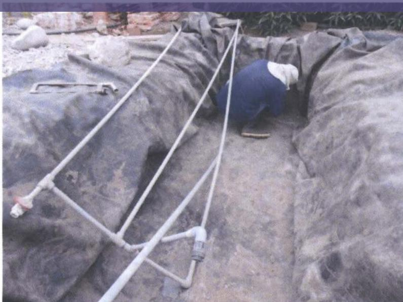
**Figura 3** Recubrimiento con geomembrana de HDPE de 4" e instalación del sistema de recolección
