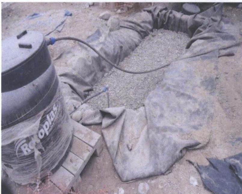
**Figura 12** Tanque de almacenamiento inicial (ROTOPLAST de 250 L)
