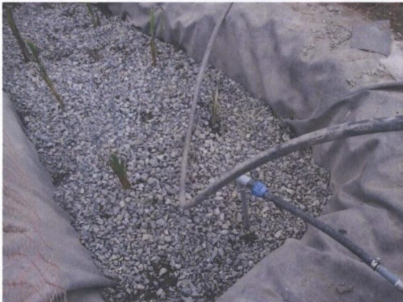
**Figura 16** Vista del sistema de ingreso del afluente al HAFSS
