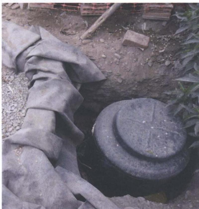
**Figura 6** Tanque de almacenamiento final (ROTOPLAST de 250 L)
