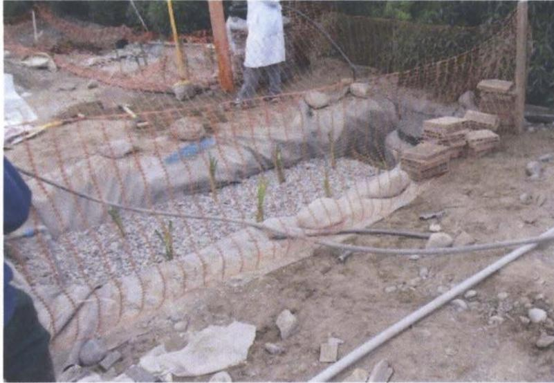
**Figura 15** Vista de la malla de seguridad instalada alrededor del HAFSS
