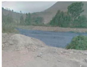
CARENTE INFRAESTRUCTURA VIAL (PUENTES)
