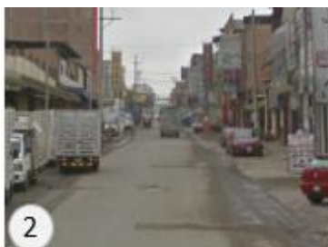
Av. Solidaridad (6m de ancho) Cuenta con 2 carriles, doble sentido.
