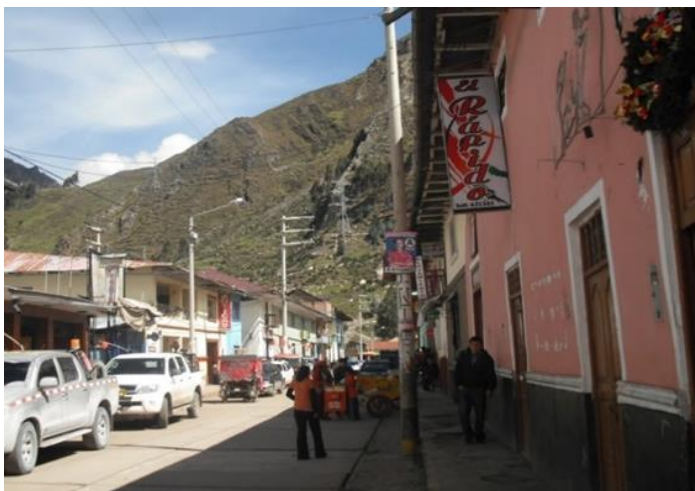
Fachadas de las casonas de la plaza.
