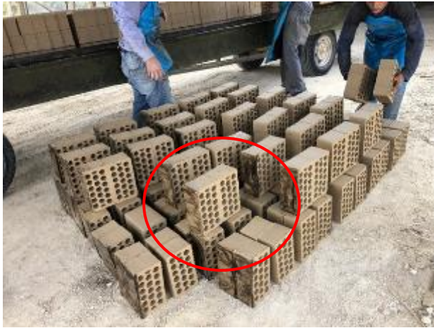
Ilustración 8: Apilamiento de ladrillo KingKong Tipo I en 2 filas.
