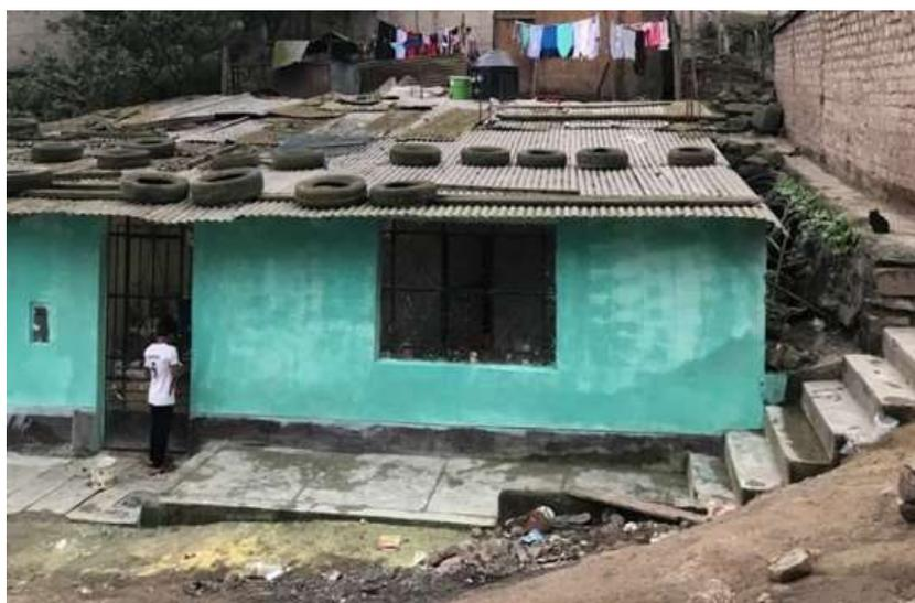
*Fig. 10. Escalera de concreto con un tramo de vereda. Estado: precario, sin barandas.*
