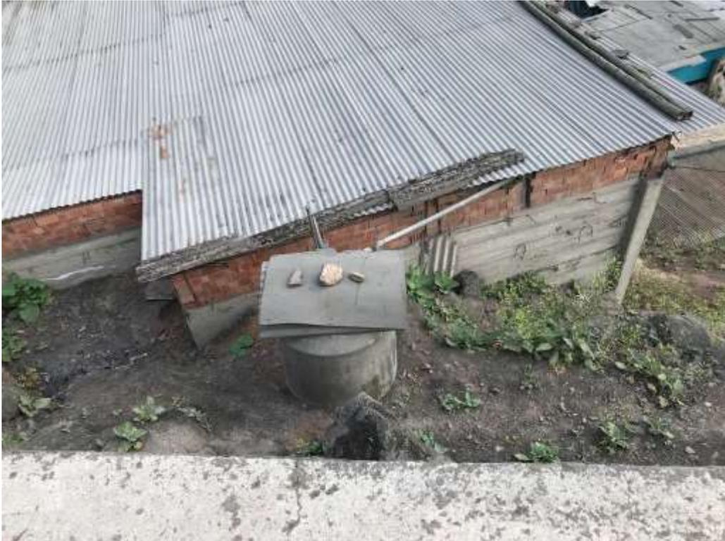
*Fig. 15. Vivienda abastecida por tanque Rotoplas. Tuberías expuestas a la intemperie.*
