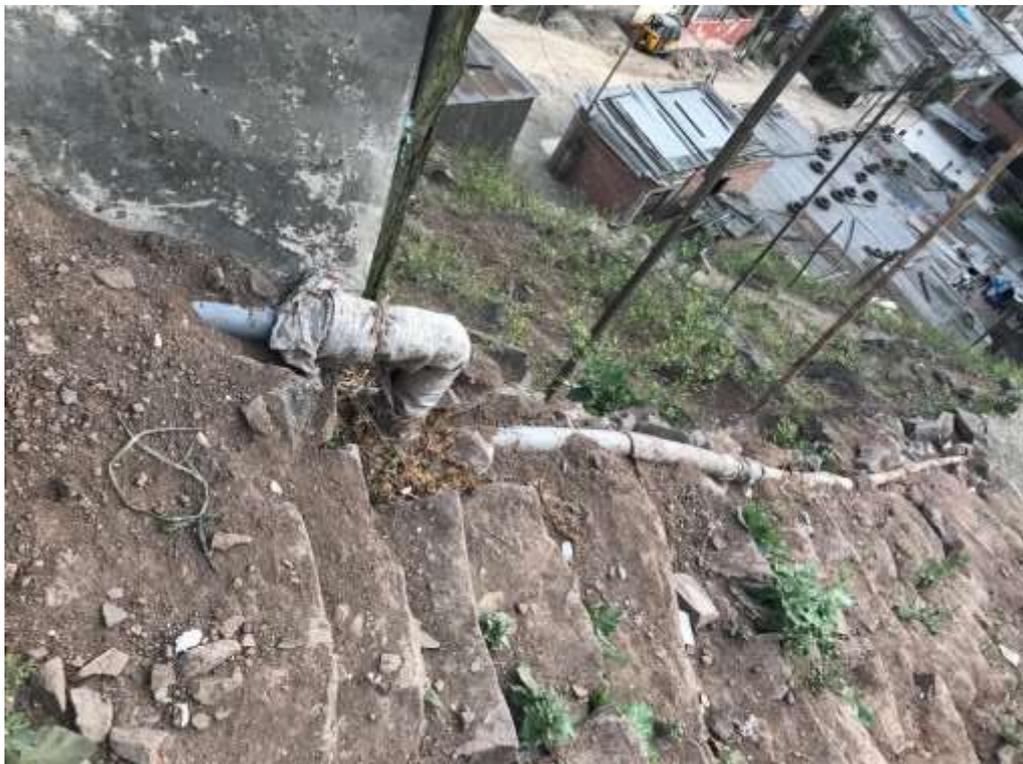
*Fig. 16. Tubería de agua expuesta forrada con tela en la escalera rustica.*
