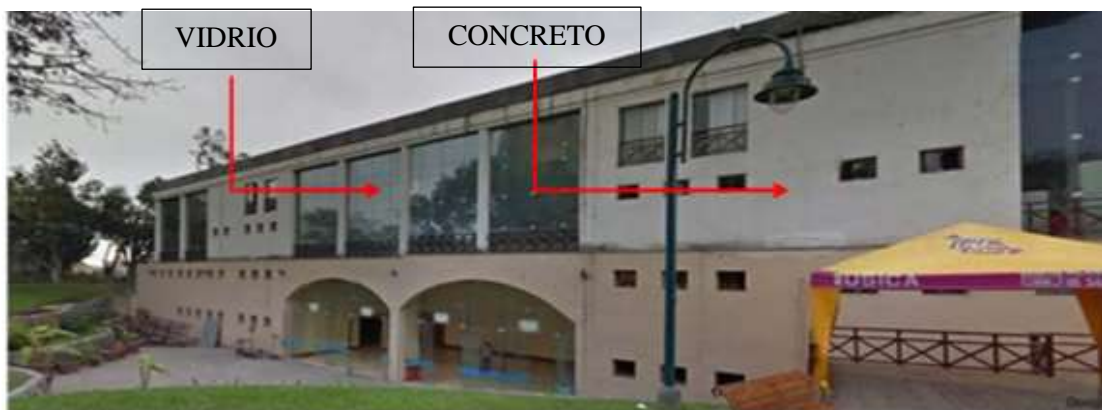
Figura N° 8: Materialidad del centro cultural Augusto B. Leguía, Fachada Frontal.
