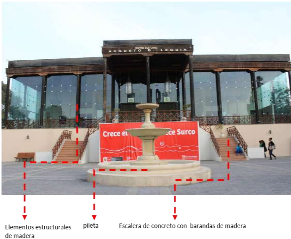
Figura N° 5: Descripción de la fachada del centro cultural.
