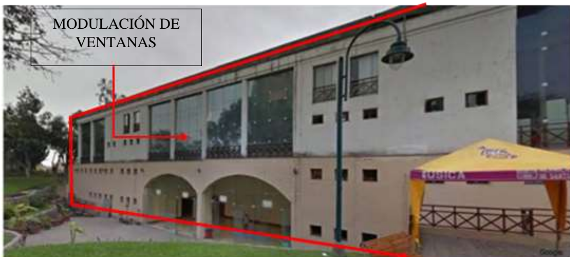
Figura N° 10: Forma Arquitectónica del centro cultural Augusto B. Leguía, Fachada Lateral
