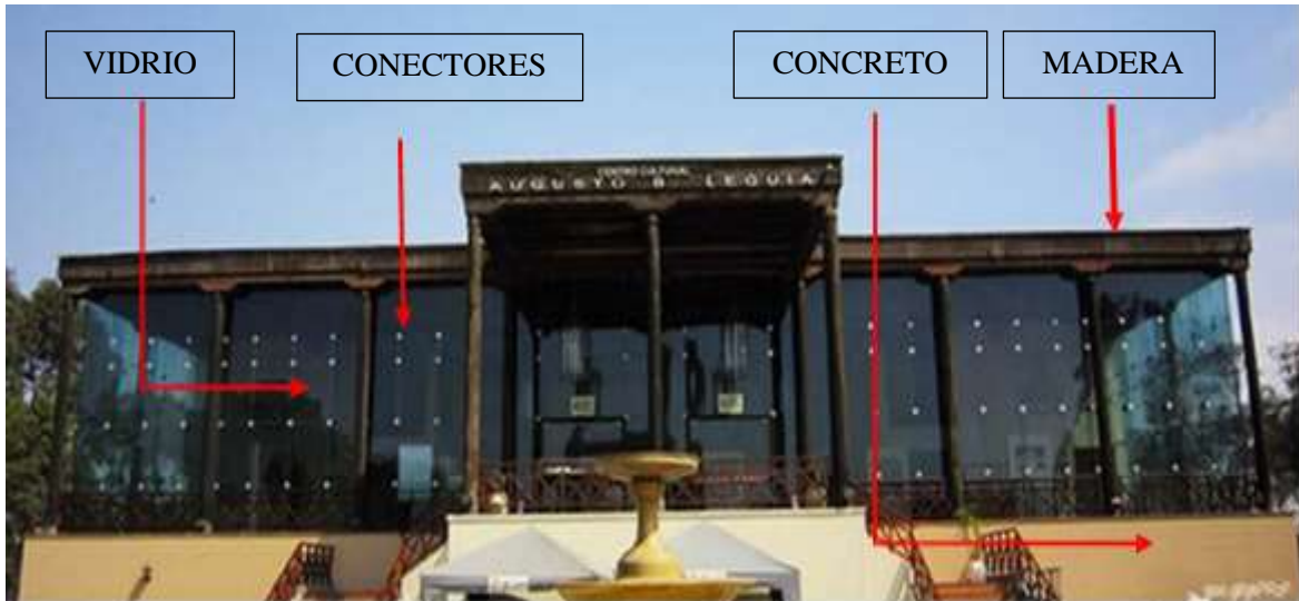
Figura N° 7: Materialidad del centro cultural Augusto B. Leguía, Fachada Frontal.
