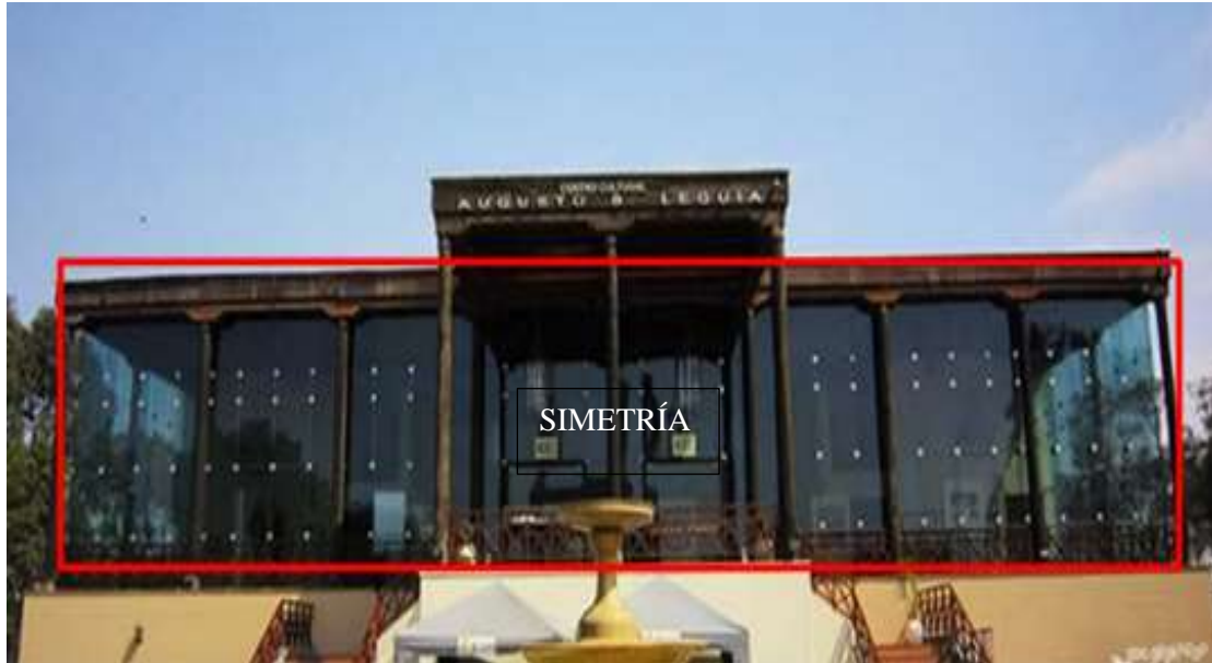
Figura N° 9: Forma Arquitectónica del Centro cultural Augusto B. Leguía, Fachada principal.
