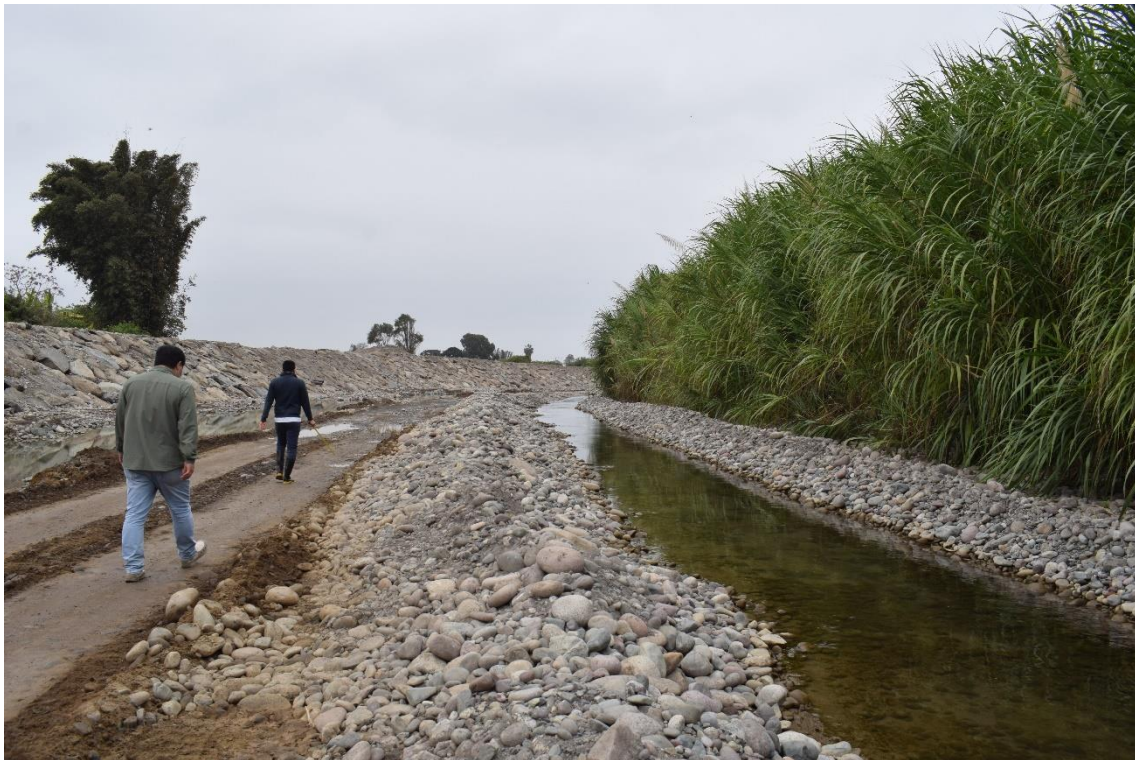
Anexo 9 De vista a nivel del Tramo N°2
