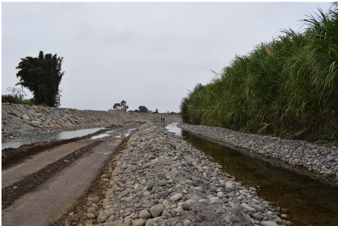
Anexo 10 De vista a nivel del Tramo N°2
