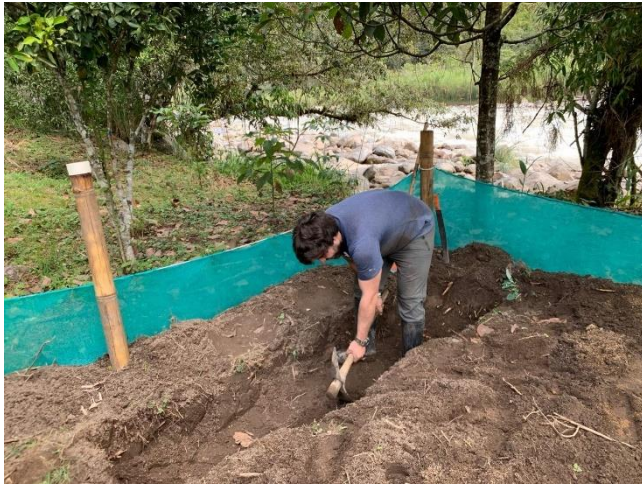
Foto 3. Se excavó las dos parcelas.
