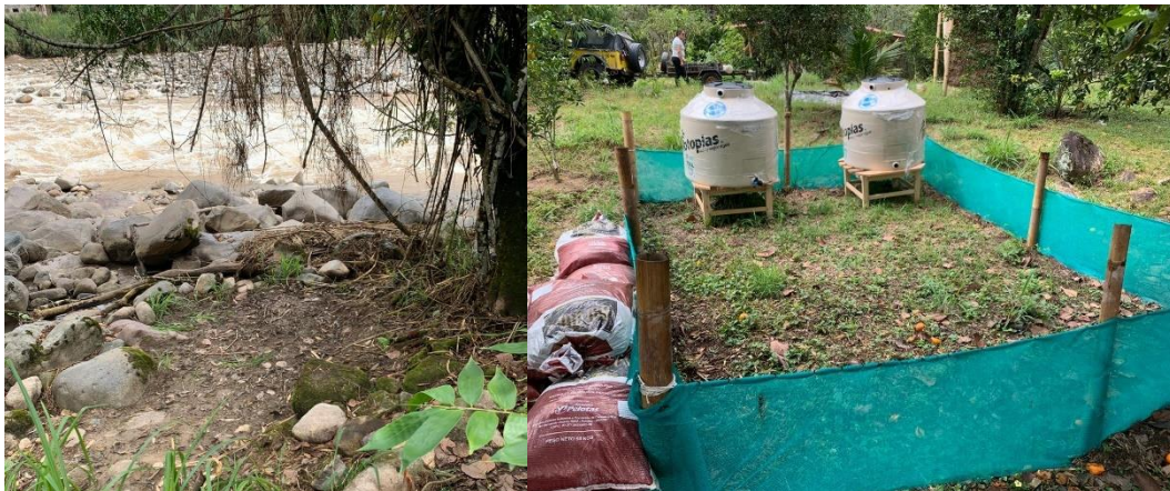
Foto 2. Limpieza de las dos áreas de estudio, cercado y colocación de los tanques.
