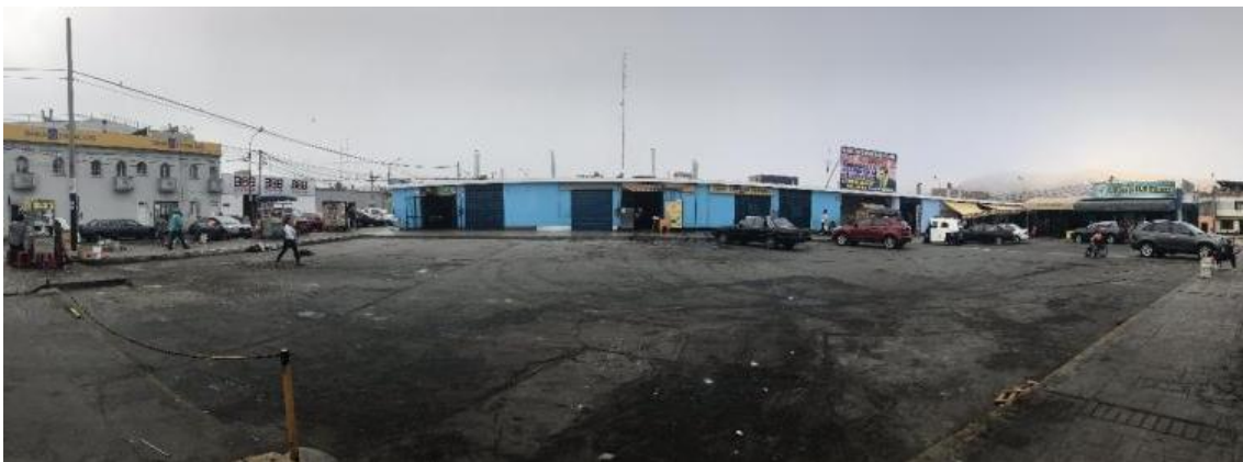
Figura 5.9 Estado actual del Mercado Modelo N°1 del distrito de Chorrillos. Elaboración propia.
