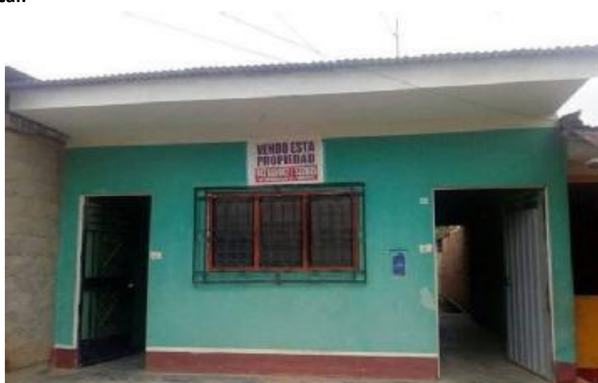
Figura 34 Fachada del local
