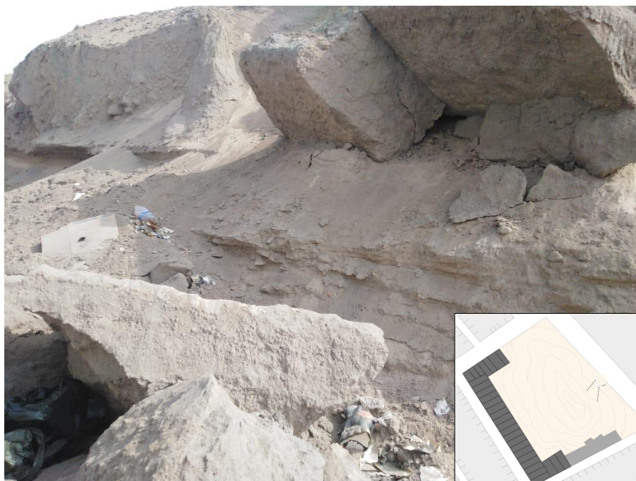
Figura N° 29: Revestimiento de los muros exteriores de la huaca de Cruz de Armatambo (Chorrillos). Copyright 2019 por Milla F.
