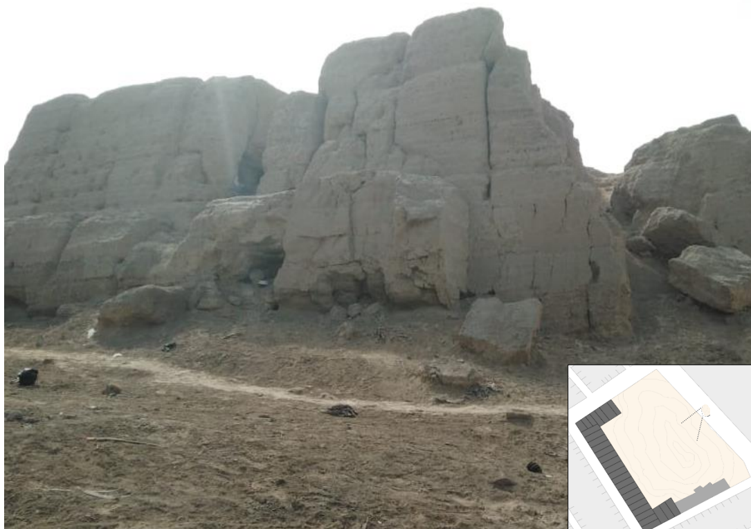
Figura N° 25: Muros de la huaca de Cruz de Armatambo (Chorrillos). Copyright 2019 por Llanos M.
