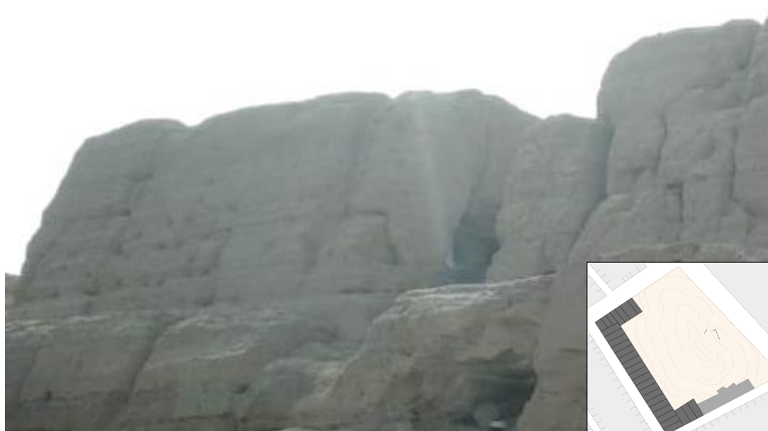
Figura N° 28: Revestimiento de los muros exteriores de la huaca de Cruz de Armatambo (Chorrillos). Copyright 2019 por Milla F.
