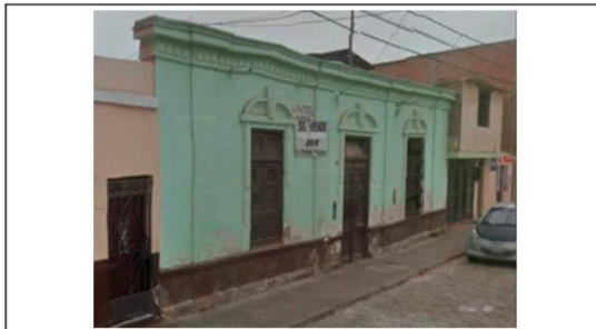
19 Edificación abandonada Vacío Funcional Francisco Cabrera 1255
