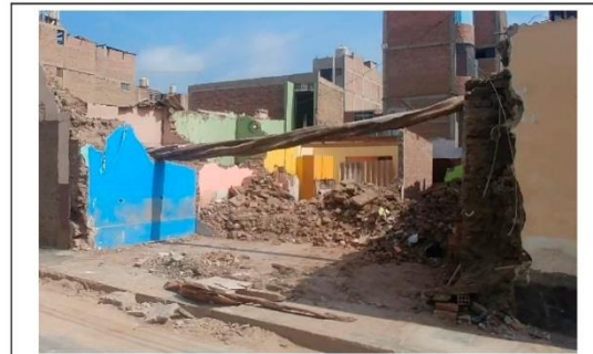
42 Lote vacío Vacío Funcional José Sucre 292
