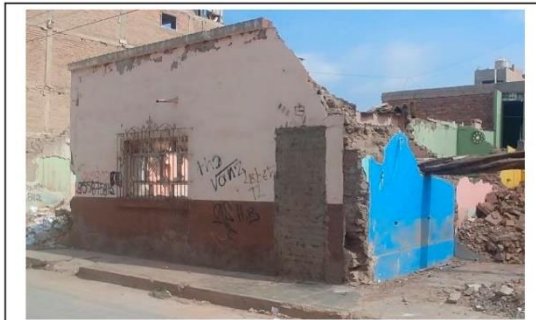
41 Lote vacío Vacío Funcional José Sucre 286
