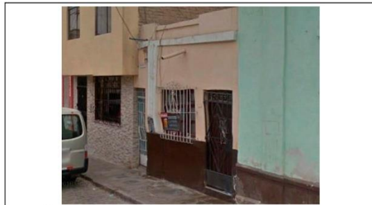
20 Edificación abandonada Vacío Funcional Francisco Cabrera 1259
