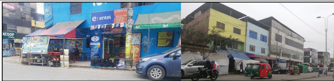
Ficha 07: Deterioro del espacio público, Av. Revolución - Villa el Salvador del sector II. Fuente: Por Nilber Cardozo, Neshy Liberato, Anel Sarabia. (2019).
