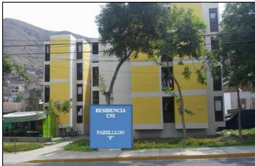
Fotografía 7: Residencia de la Universidad Nacional de Ingeniería Pabellón P
