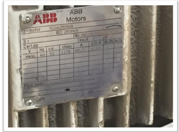
1. Verificando el factor de potencia en la placa de los motores – Medición en campo
