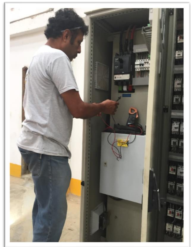
3. Medición en campo para hallar la potencia
