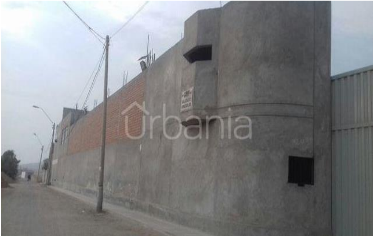
Figura N°04 Fachada de la empresa Macasaco
